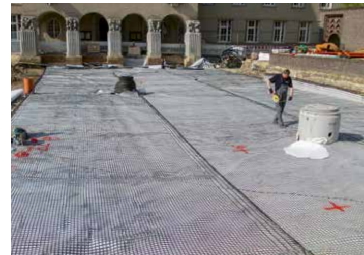
Gittergewebe erhöhen die Belastbarkeit des teils moorigen Untergrundes
