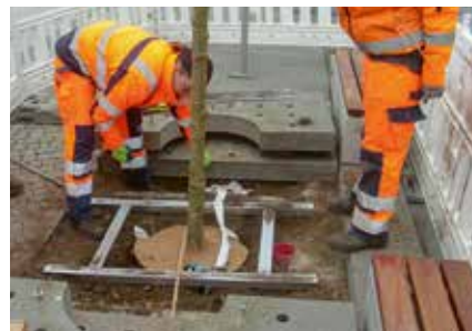
Baumpflanzungen bereichern auch künftig das Stadtbild
