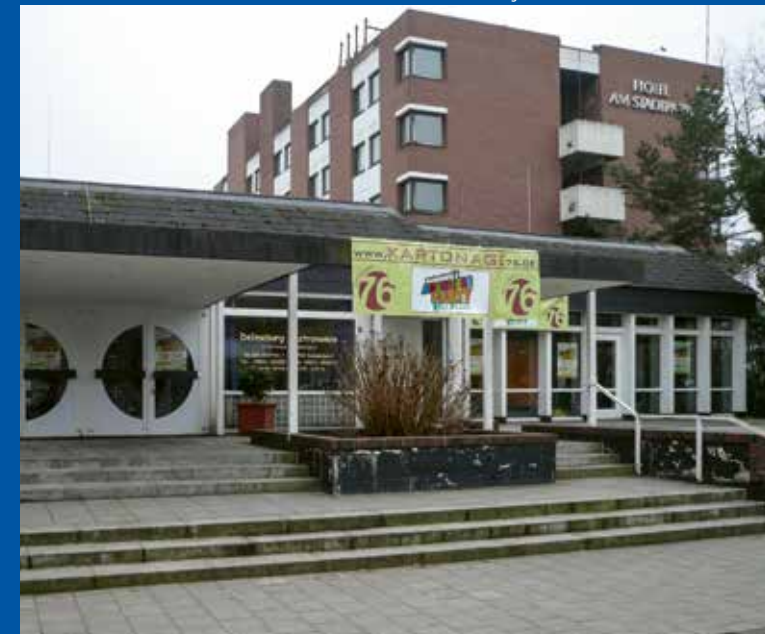
▲ Delmeburg (Hotel) vor dem Abbruch
